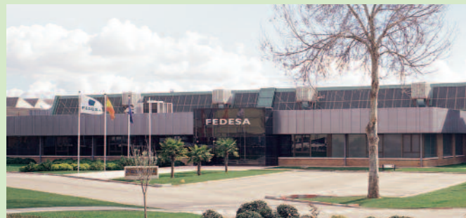
Fachada de planta principal.
